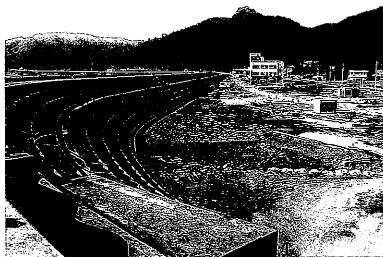
写真3 防潮堤からみた田老町
