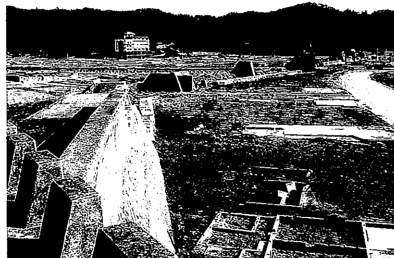
写真4 破壊された防潮堤
